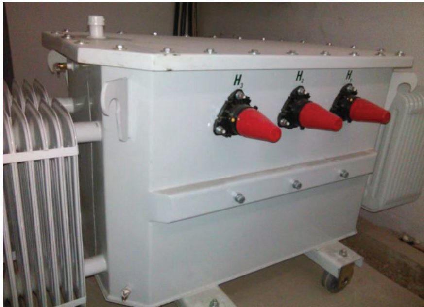
Figura 2.14 Transformador convencional de frente muerto, bushing insert de M.V.
