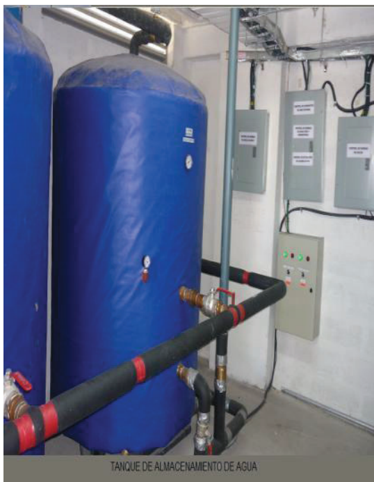
Figura 2.41 Tanque de almacenamiento de agua
