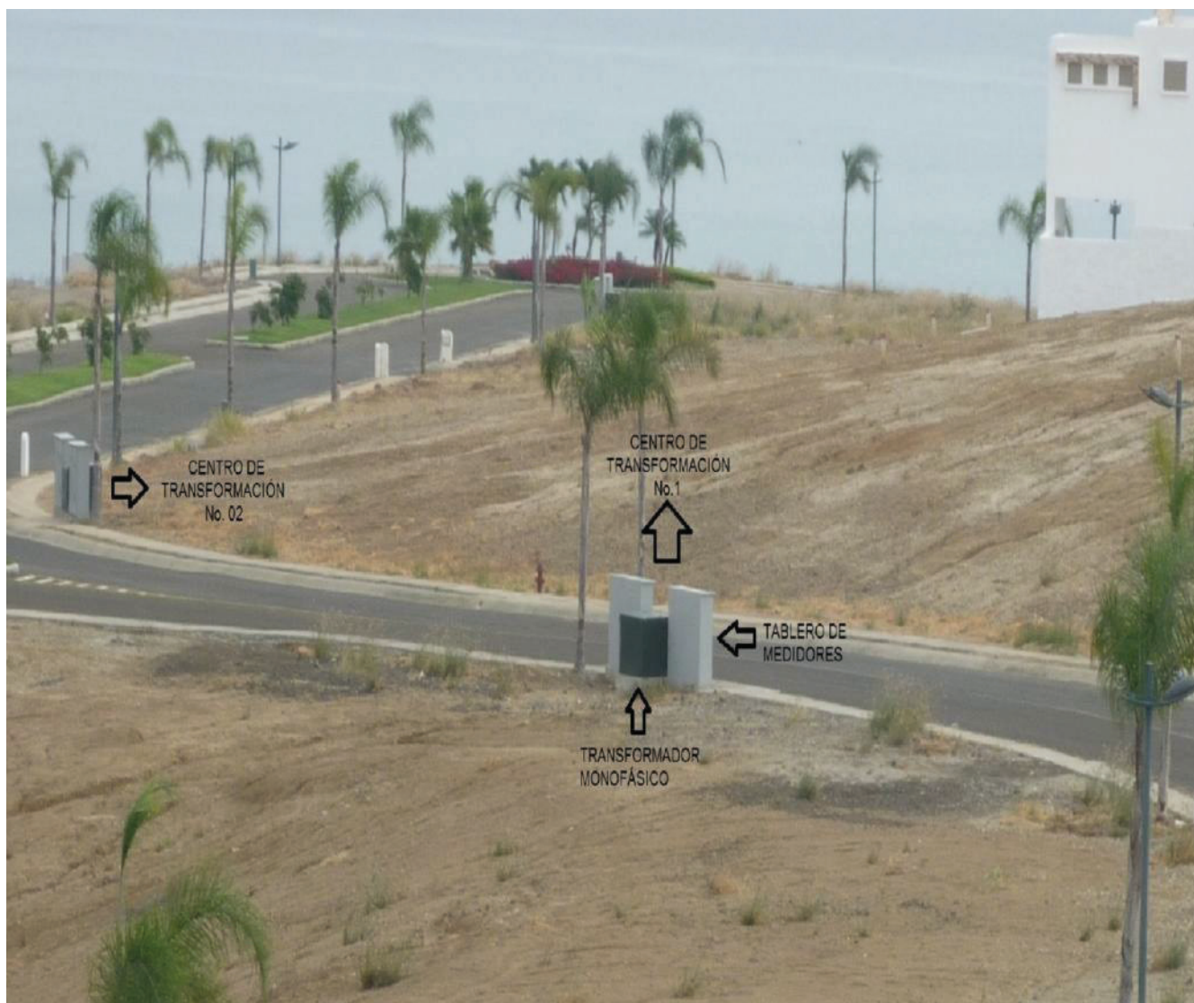
Figura 4.11 Ubicación de equipos para red eléctrica subterránea
