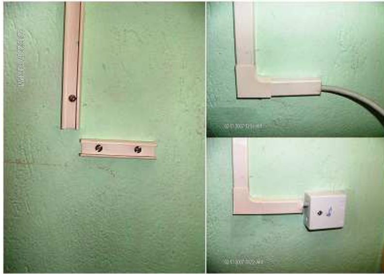
Figura 76 Rutas mediante canaletas
