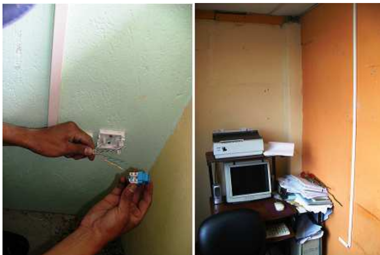
Figura 75 Armado de los cajetines
