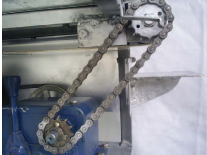
Figura 3.7 Acople del motorreductor y el rodillo de la banda.
