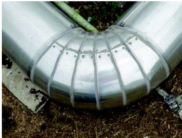
Figura 2.32. Tubería REE, arreglo mitrado. Fuente: (Propia)
