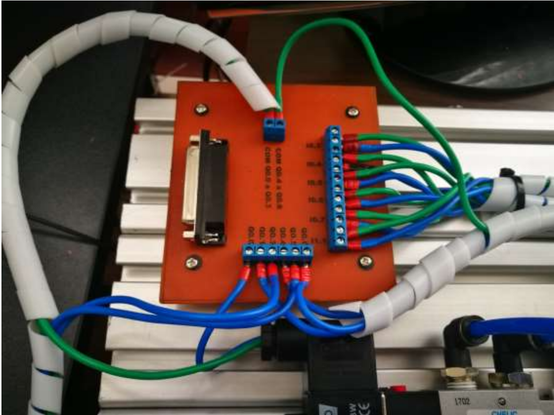
Cableado de los elementos en el panel
