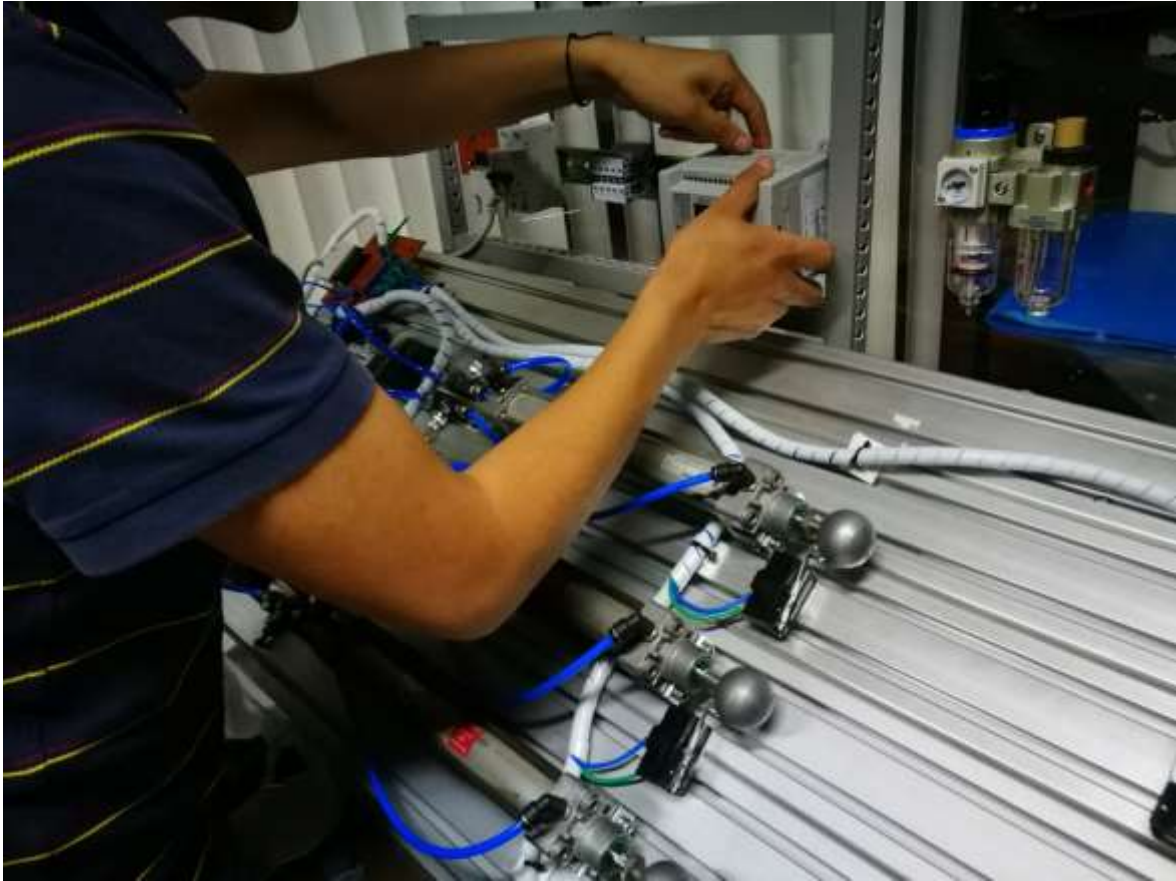
Montaje de los elementos de control
