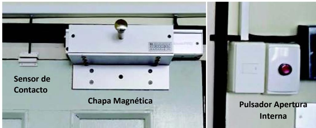
**Figura 2.71** a) Ubicación del sensor de contacto y chapa magnética (b) Pulsador de apertura
