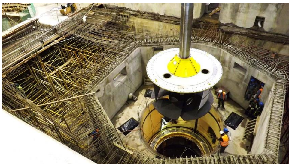
Figura A.3. Instalación de rodete de la turbina se realiza en proyecto hidroeléctrico Manduriacu. (Fuente: https://www.celec.gob.ec/enemorte )
