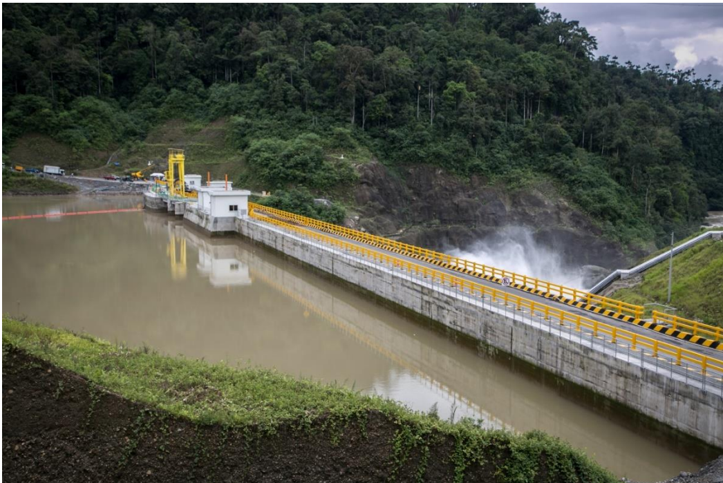
Figura A.2. Presa – Central hidroeléctrica Manduriacu. (Fuente: http://www.energia.gob.ec/manduriacu )
