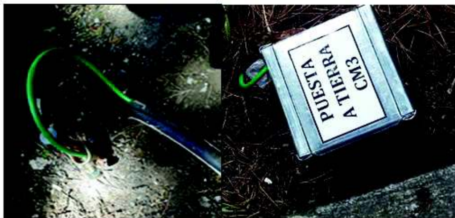
Figura 26: Instalación de Varilla Cooperweld.
