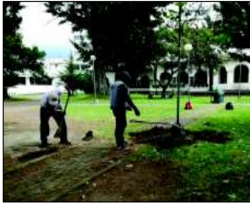
Figura 16: Intervención de ductos.
