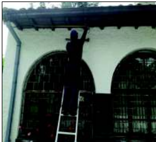
Figura 22: Toma de distancias para ubicación de tubería EMT.
