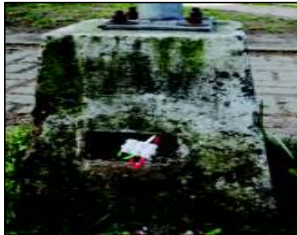
Figura 25: Cableado de luminarias.
