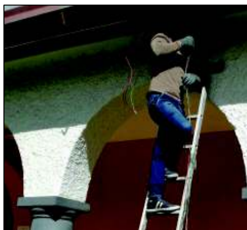
Figura 30: Cableado de luminarias.
