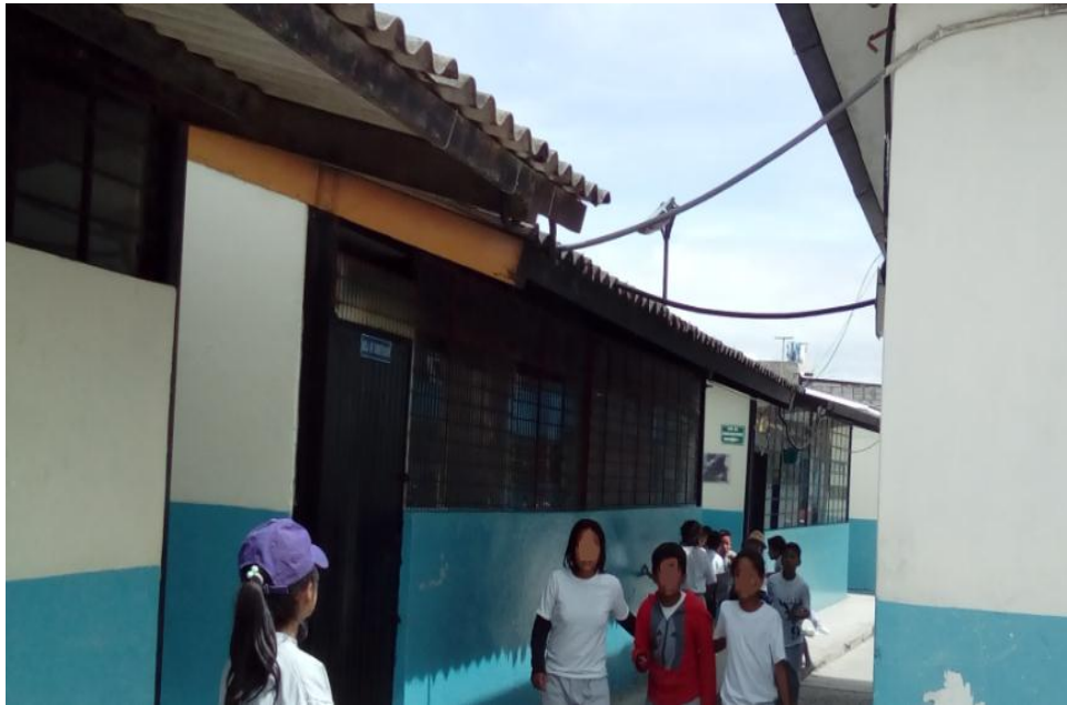
Figura 15. Detalle zona 6 de instalación de las cámaras.
