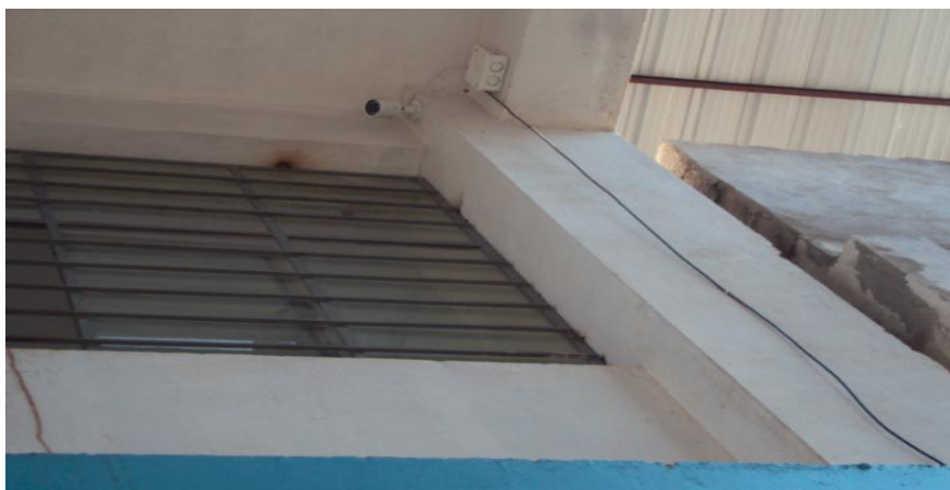
Figura 30. Cámara instalada zona 2.
