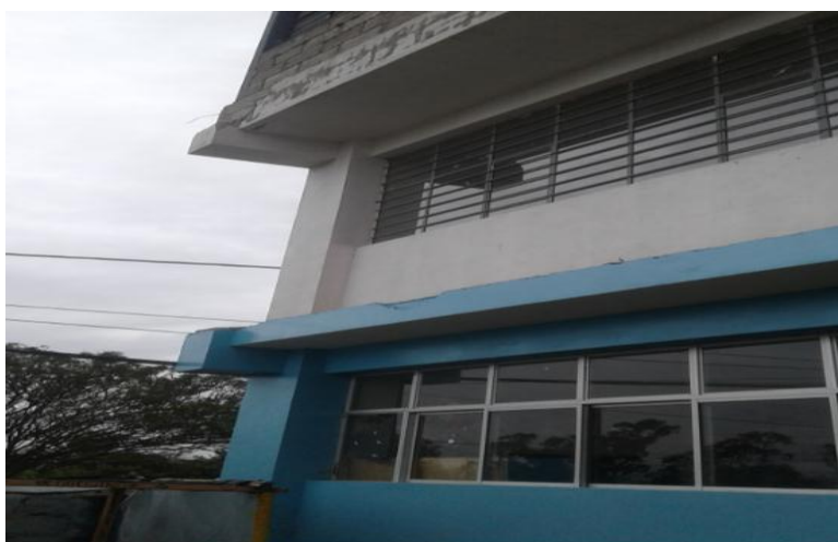
Figura 10. Detalle zona 1 de instalación de las cámaras.
