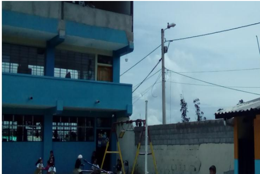
Figura 12. Detalle zona 3 de instalación de las cámaras.
