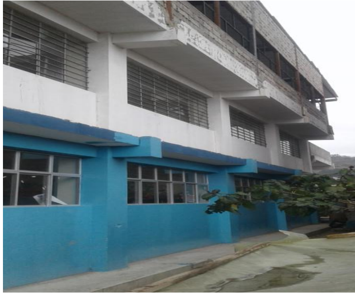
Figura 11. Detalle zona 2 de instalación de las cámaras.
