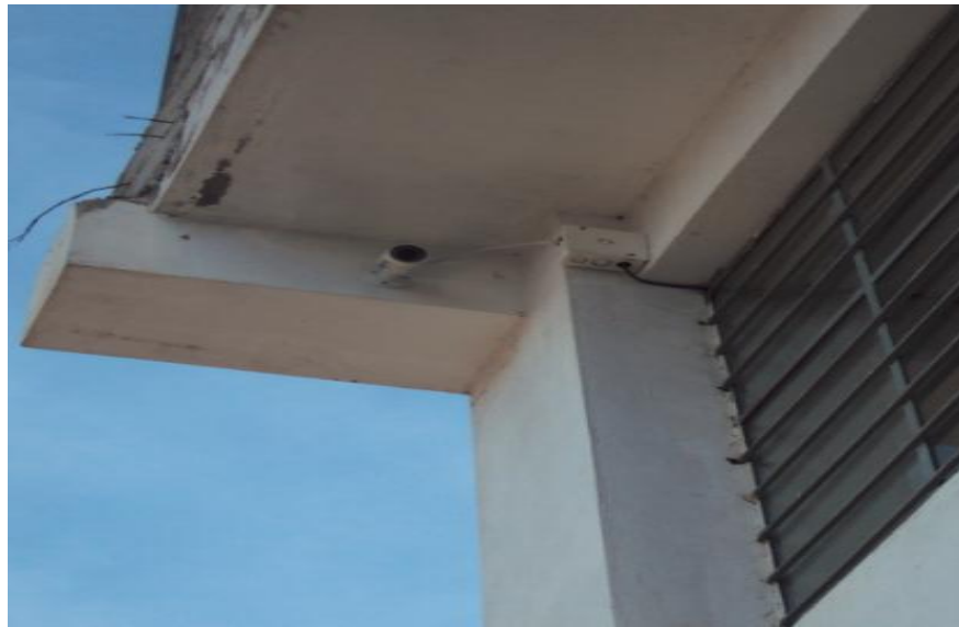
Figura 29. Cámara instalada zona 1.
