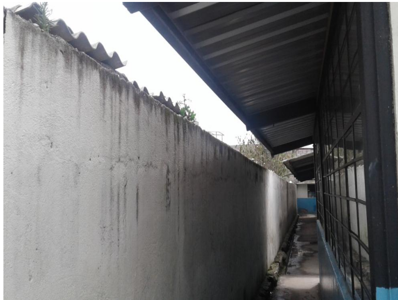
Figura 13. Detalle zona 4 de instalación de las cámaras.
