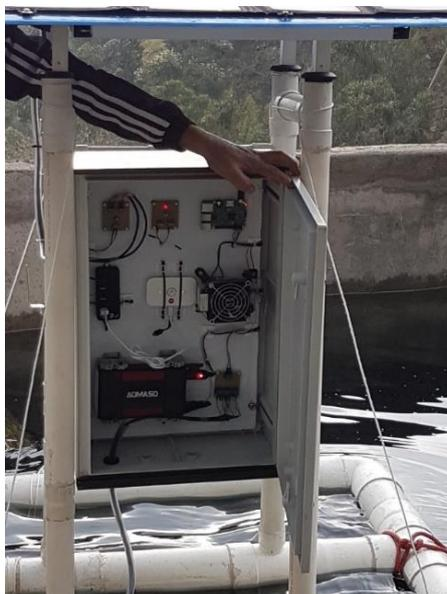
**Figura 3.9.** Caja de comunicaciones sin filtraciones de agua después de la lluvia.
