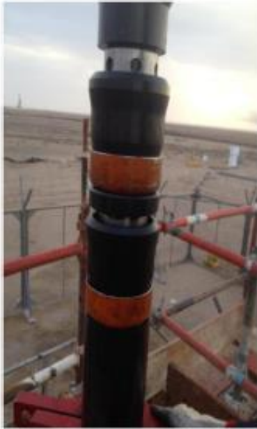
Previo a ser corrido en el pozo
