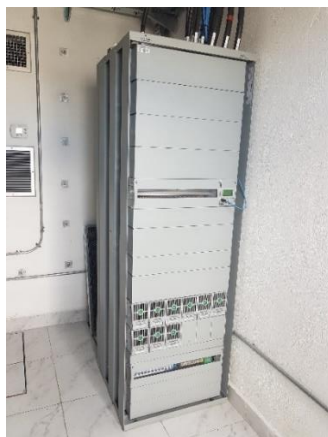
Figura 3.14 Rectificador de Energía
