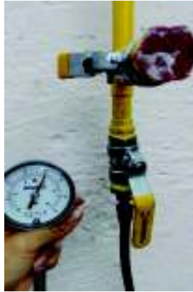
Figura 2.10. Válvula antes y después del elemento roscado, con el cual se simulará la fuga. (Fuente: propia).
