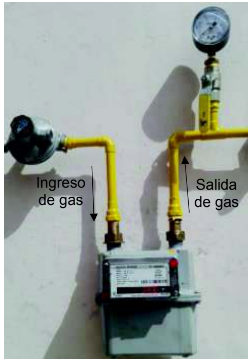
Figura 2.6. Medidor de volumen, apreciación 0,001 m 3 . (Fuente: propia).
