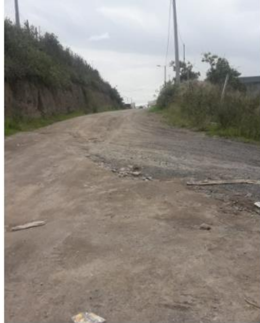
Figura 22. Calle de Tierra
