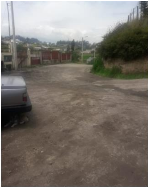
Figura 20. Calle de Tierra
