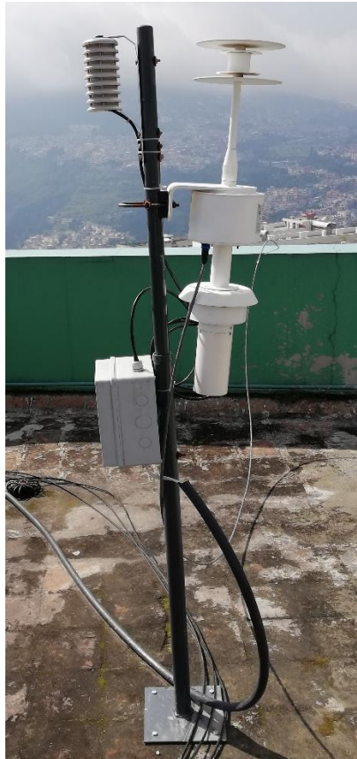
Figura 3.21. Instalación de la estación prototipo y estación MET-4A
