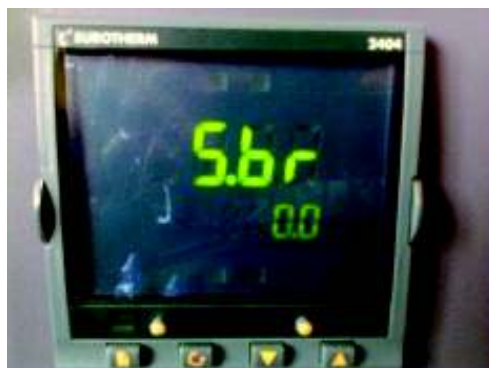
Figura 3.25. Mensaje de alarma por desconexión del sensor de temperatura.
