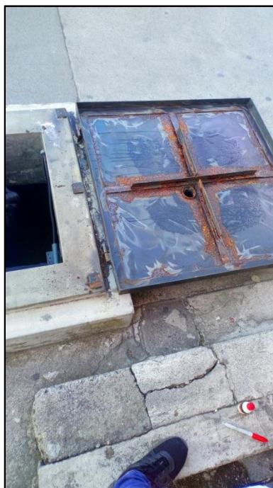
Figura I. Cisterna ICB SIS
