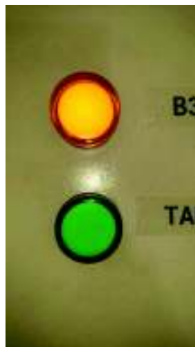
Figura 17 Luces piloto de accionamiento breaker principal y contador principal
