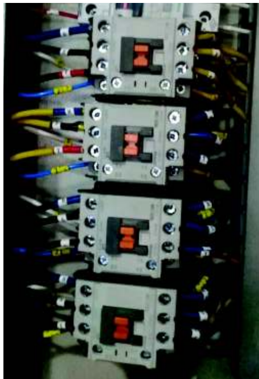
Figura 27 Identificación de cables.
