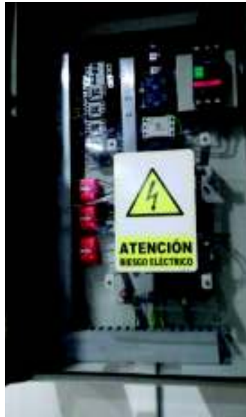
Figura 7 Acondicionamiento del cableado instalado
