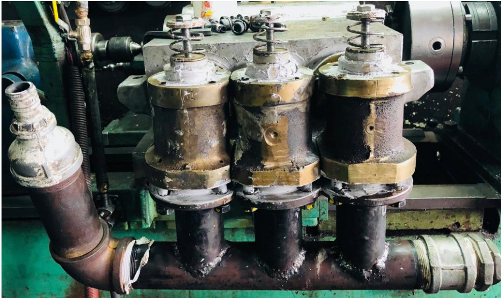
Figura 2.44. Instalación de válvulas de descarga. (Fuente propia)
