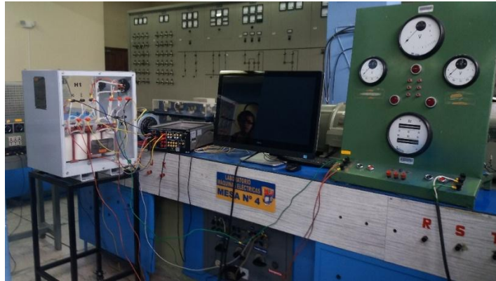
Figura 4.22. Conexión delta abierta conectado a una carga RL en el laboratorio de máquinas eléctricas
