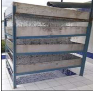
Figura 19. Aireador correspondiente a la planta de tratamiento
