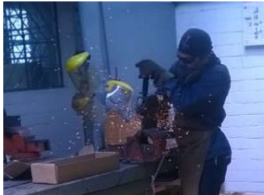
Figura 2.1 Biselado de las placas de acero. (Fuente: propia)
