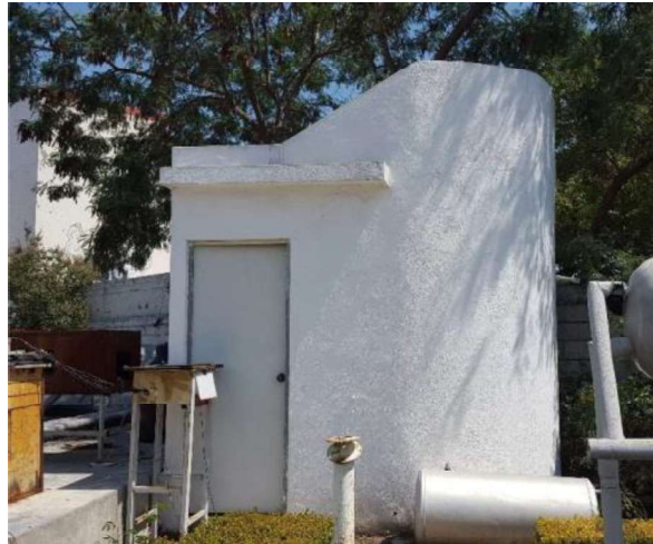
Figura 2.1. Cuarto de monitoreo- Casa Solar ITESM, campus Monterrey.
