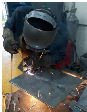
Figura 2.23. Realización del cordón de soldadura. Fuente: (Propia)
