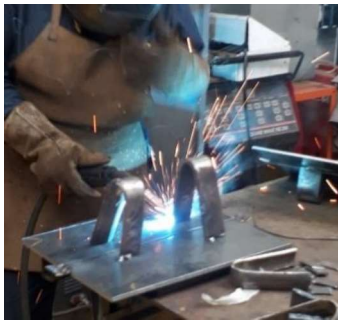
Figura 2.22. Colocación de Respaldos, con separación de 2 [mm]. Fuente: (Propia)
