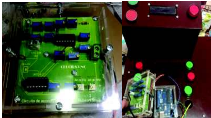
Figura 3. 52 – Presentación y montaje del circuito de acondicionamiento
