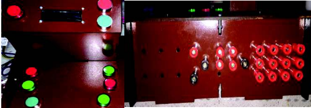
Figura 3. 39 – Montaje de componentes.
