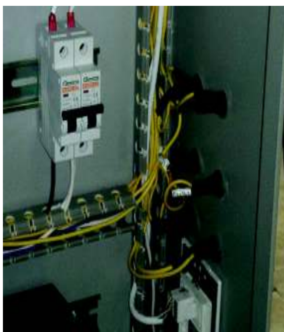
Figura 3. 16 – Conexión y aislamiento de los porta fusibles.
