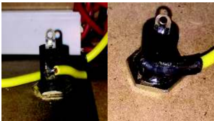
Figura 3. 64 – Soldado y aislamiento de los terminales de fusible.
