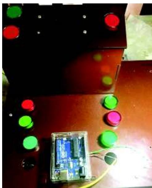
Figura 3. 43 – Instalación del Arduino UNO.
