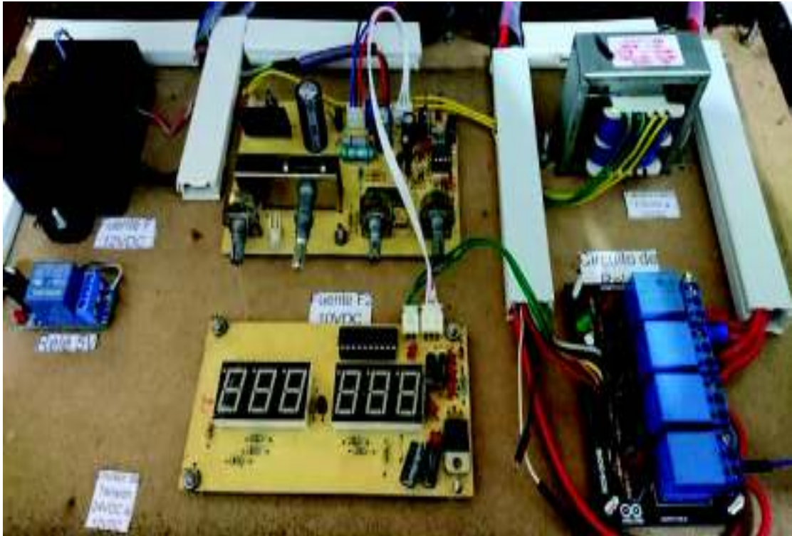
Figura 3. 55 – Montaje y cableado parte interna de la Planta
