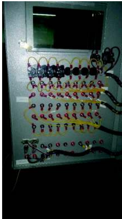
Figura 3. 12 – Conexión eléctrica finalizada
