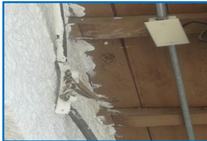
Figura 17. Instalación de tubo conduit y cajetín galvanizados.
