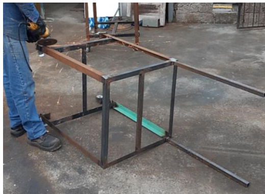
Figura 3.7 Pulido de las estructuras metálicas.
