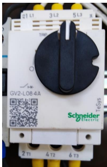
Figura 3.11 Disyuntor GV2L08.
