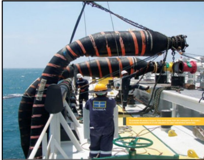
Figura 1.5: Mangueras Flotantes (Terminal Marítimo) Fuente: www.ocpecuador.com
