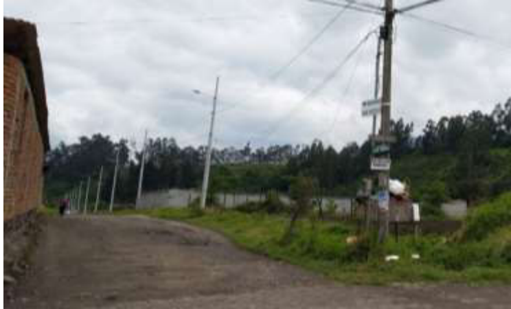
Figura 3.2 Ubicación de postes de alumbrado público a lo largo del Pasaje San Javier 2.
