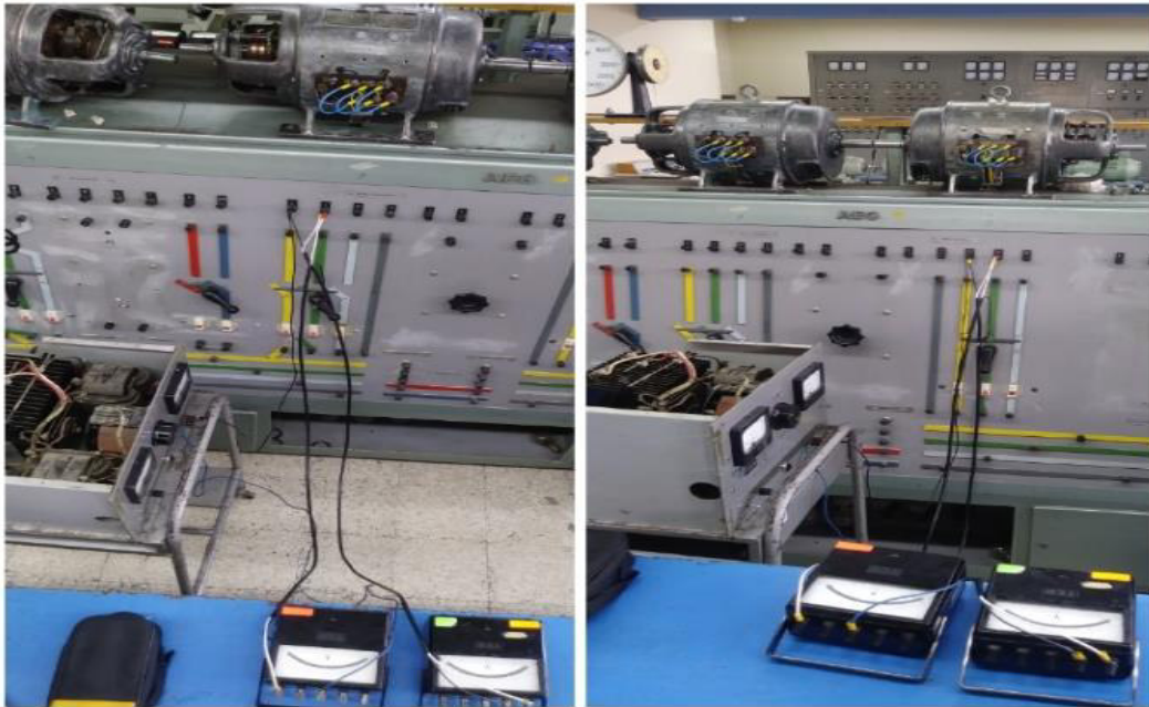
Figura 4.24. Prueba de resistencia armadura de una bobina, máquina sincrónica 1 y 2 respectivamente.
