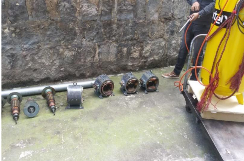
Figura 4.8. Limpieza de polvo mediante compresor
