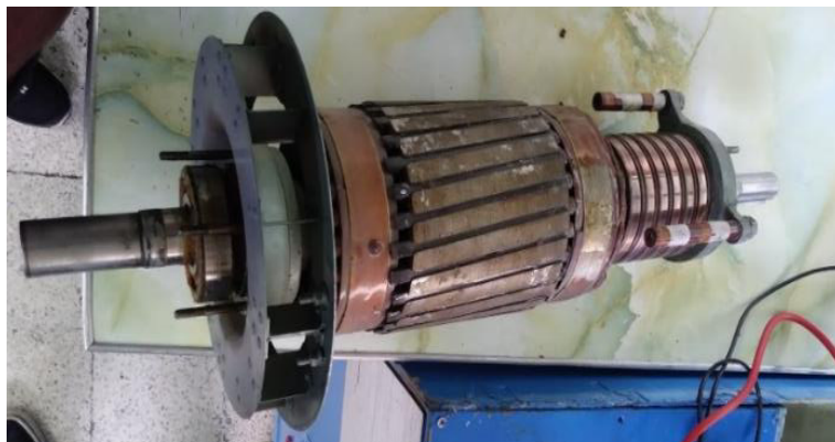
Figura 4.5. Inspección visual, rotor máquina síncrona con suciedad acumulada y desgaste de barniz.
