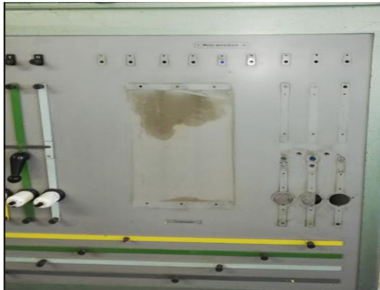
Figura 4.12. Desmontaje máquina de inducción, módulo 1.
