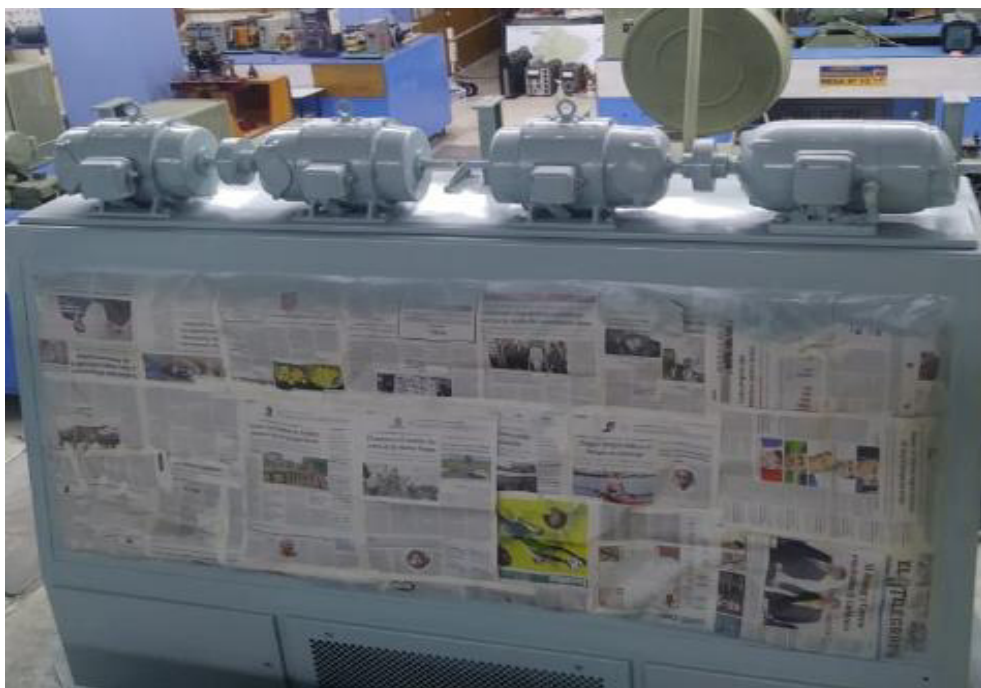
Figura 4.18. Recubrimiento para proceder a pintar los módulos.
