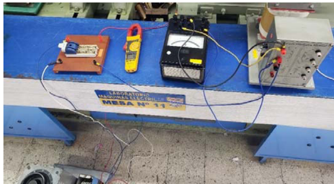
Figura 3.1 Prueba de circuito abierto del transformador monofásico
