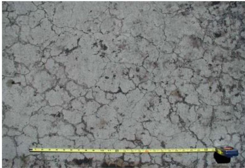
Figura 2.11 Fisuras en forma de mapas, frutos de la reacción álcali-sílice.
