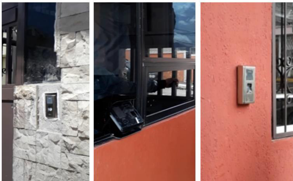
Figura 3.13 Instalación de los biométricos
