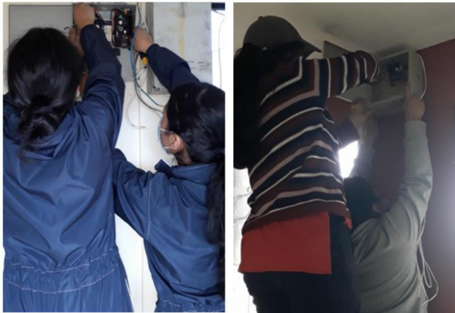
Figura 3.12 Instalación de las cajas de alimentación
