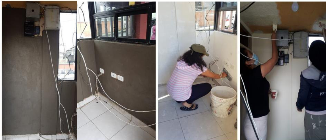
Figura 3.8 Reparaciones de la zona garita
