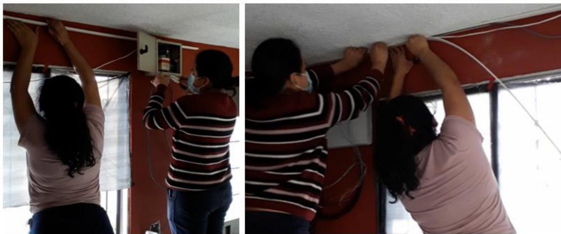
Figura 3.16 Proceso de canalización de la zona administrativa
