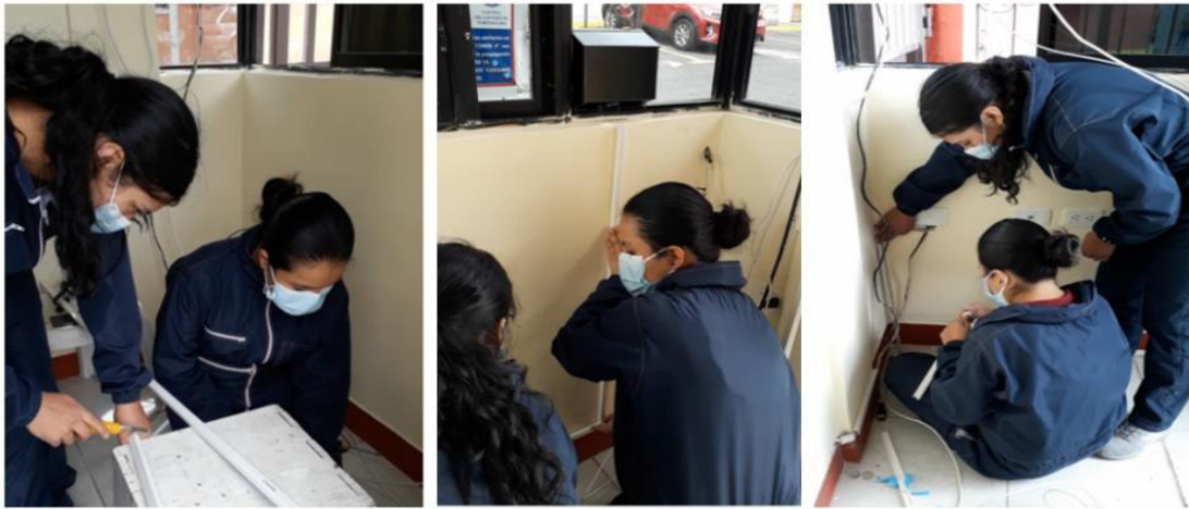
Figura 3.15 Proceso de canalización de la zona garita
