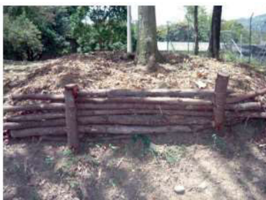
Figura 1.20. Trincho construido con ramas de la poda de árboles.
