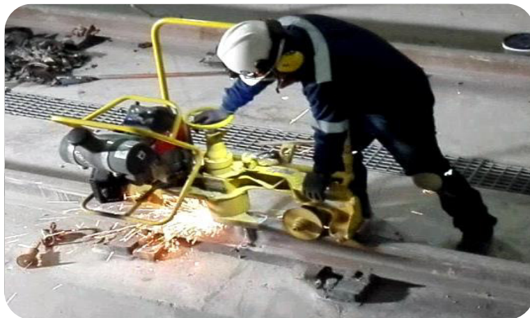
Figura 3.5 Acabado final mediante el uso de máquina en la junta soldada.
