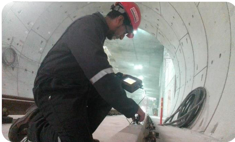
Figura 3.6 Inspección de rieles mediante la técnica de ultrasonido industrial.
