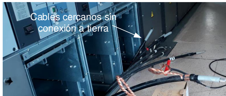
Figura 4.20. Secciones cercanas al cable bajo prueba sin conexión a tierra [Elaboración Propia].
