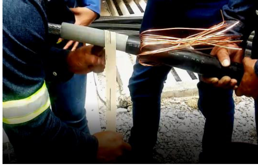
Figura 4.18. Acciones de reparación sobre del cable con falla [Elaboración Propia].
