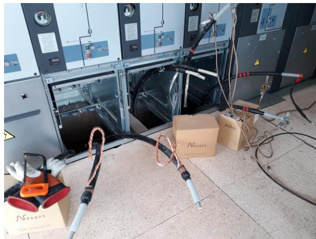
Figura 4.5. Casa de control y mando “extremo LOCAL de prueba” [Elaboración Propia].
