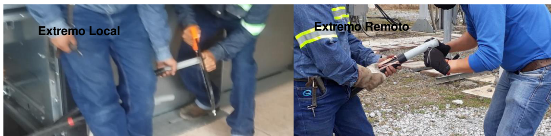
Figura 4.8. Trabajo realizado sobre los extremos del cable [Elaboración Propia].
