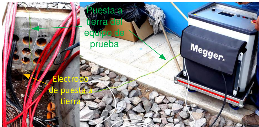
Figura 4.24. Conexión del cable de tierra del equipo de prueba VLF [Elaboración Propia].
