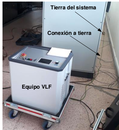
Figura 4.9. Conexión del equipo VLF a la tierra del sistema [Elaboración Propia].
