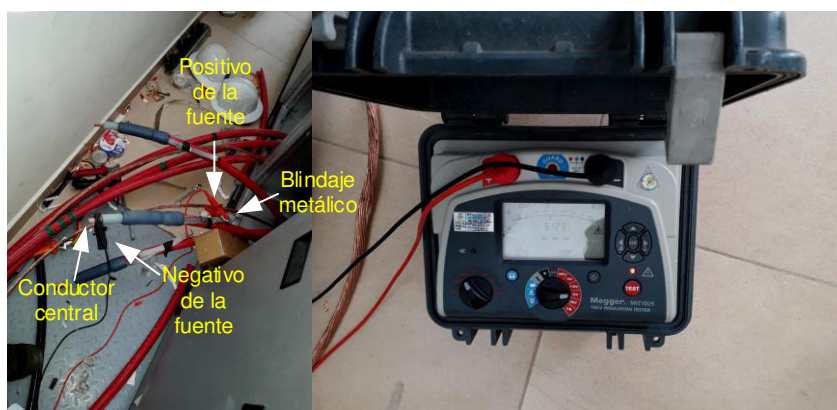
Figura 4.27. Conexión de megado de cables [Elaboración Propia].
