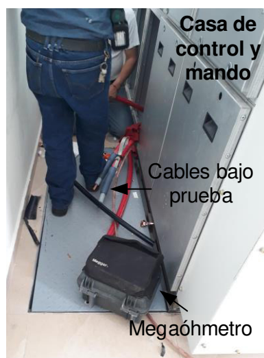
Figura 4.23. Casa de control y mando [Elaboración Propia].
