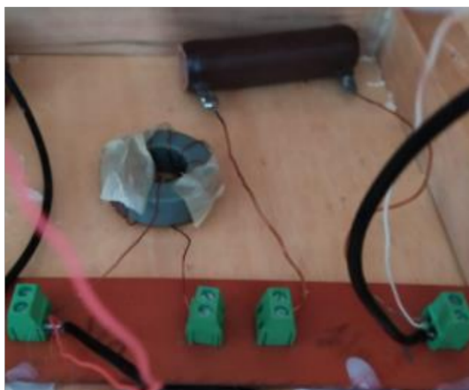
Figura 2.13. Placa instalada con la resistencia e inductancia construidas.
