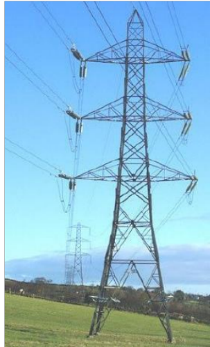
Figura 1.5. Torre de retención de doble circuito.
