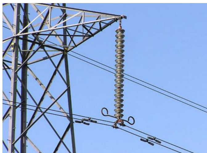
Figura 1.18. Cadena de aisladores.
