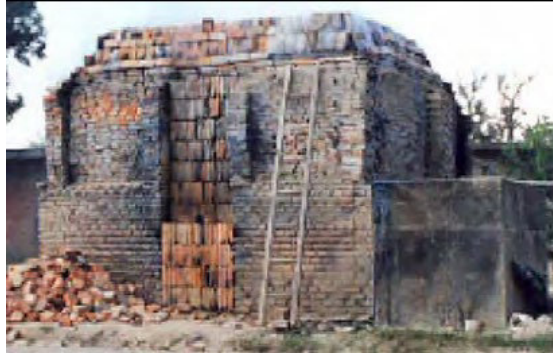
Figura 1.2. Horno Intermitente con suelo y muros laterales. Fuente: Barranzuela (2014)
