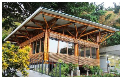
Figura 1.8. Centro de documentación del bambú construido con guadúa en Guayaquil [21].
