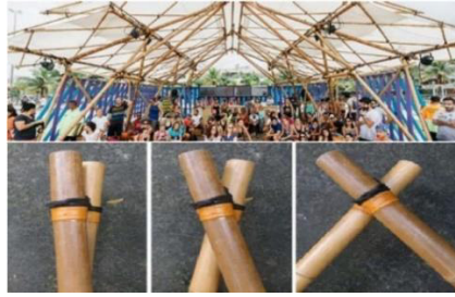
Figura 1.9. Estructura de bambú con conexiones flexibles [22].
