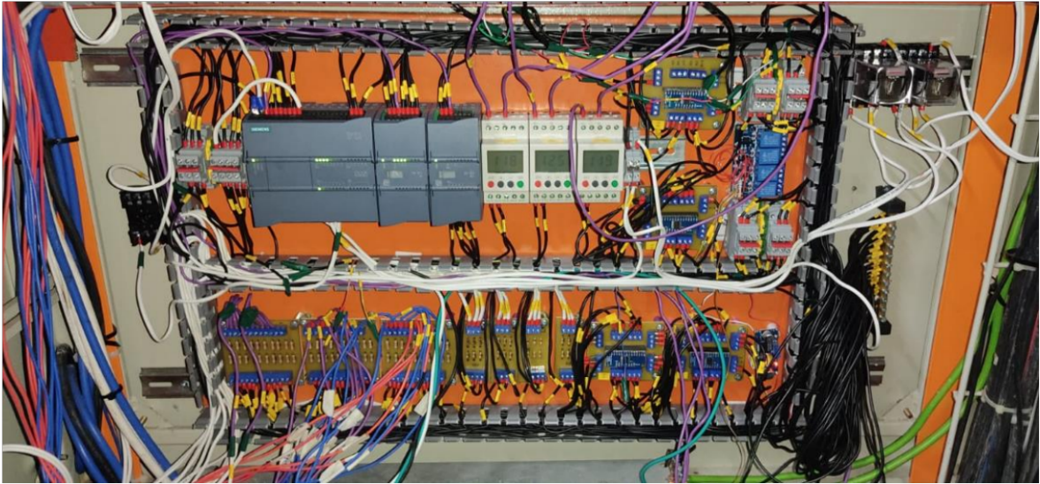
Figura 3.3. Conexión realizado en la parte de control del tablero.
