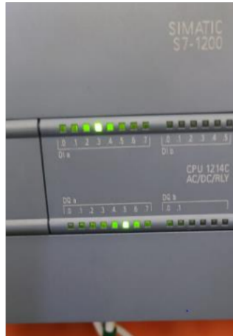
Figura 3.14. Comprobación de un nivel adecuado de diésel del tanque del generador en la entrada digital 3 del PLC.
