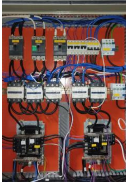
Figura 3.2. Conexionado realizado en la parte de potencia del tablero.
