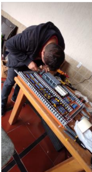
Figura 5.23. Colocación de las borneras de control en el Riel Din.
