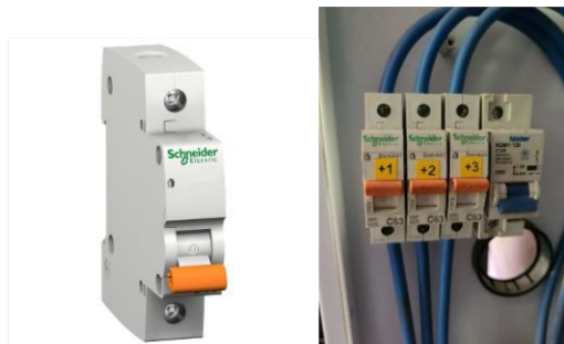
Figura 5.10. Breakers para baterías.
