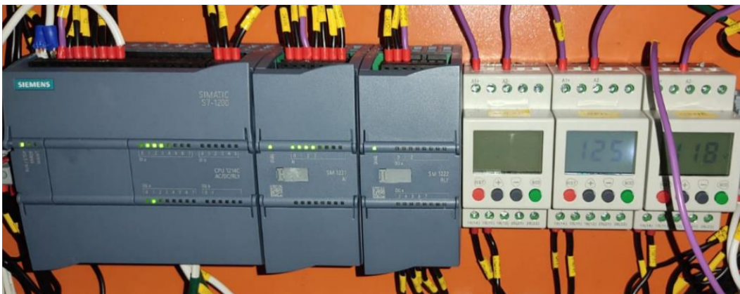
Figura 3.12. Valores de voltaje presentes en los relés de fase.
