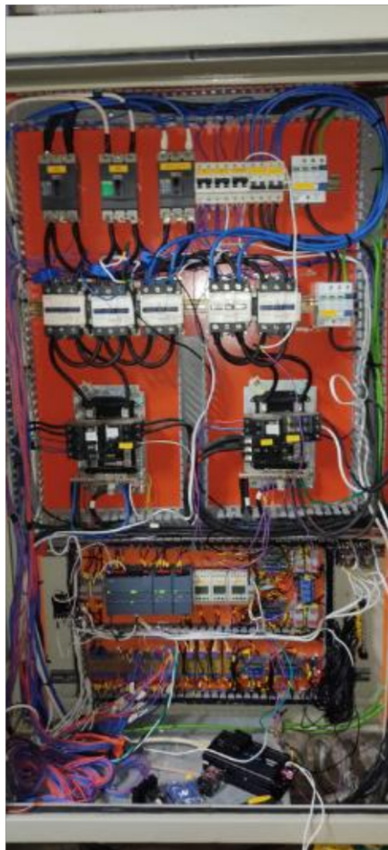
Figura 3.1. Conexionado del tablero eléctrico del sitio.
