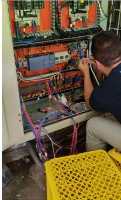
Figura 5.26. Conexión del cableado proveniente de las baterías y con los cables de color azul y rojo provenientes de los paneles solares que faltaban conectar a las dos primeras placas divisoras de voltaje.
