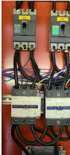
Figura 3.35. Red eléctrica suministrando energía a la finca al ser activada remotamente.
