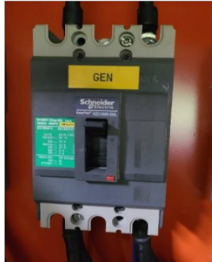
Figura 5.8. Breakers de caja moldeada.
