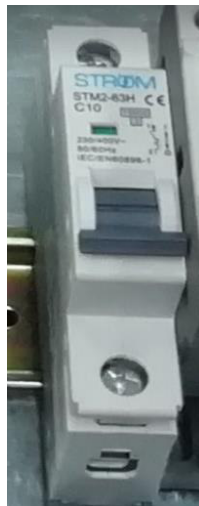
Figura 3.8. Interruptor termomagnético de 10 (A) curva C.
