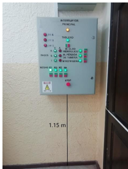
Figura 3.29. Instalación del tablero de alimentación
