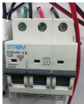
Figura 3.6. Interruptor termomagnético curva C de 20 (A).
