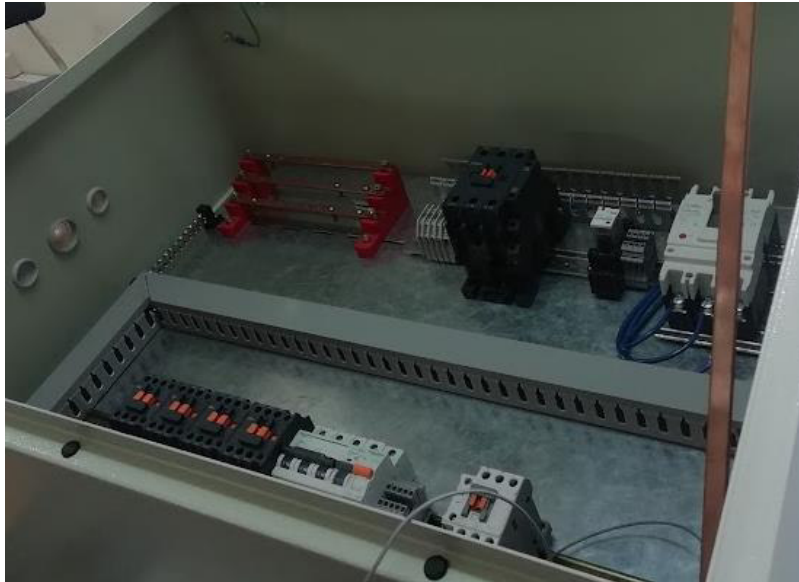
Figura 3.19. Disposición de instrumentos de protección y mando
