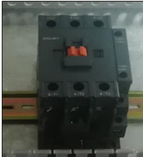
Figura 3.5. Contactor principal marca STROM categoría AC3.
