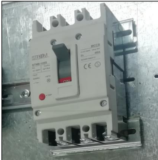
Figura 3.3. Dispositivo termomagnético de caja moldeada de 40 (A) marca STROM.
