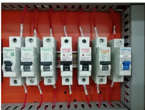
**Figura 3.8.** Instalación de protecciones
