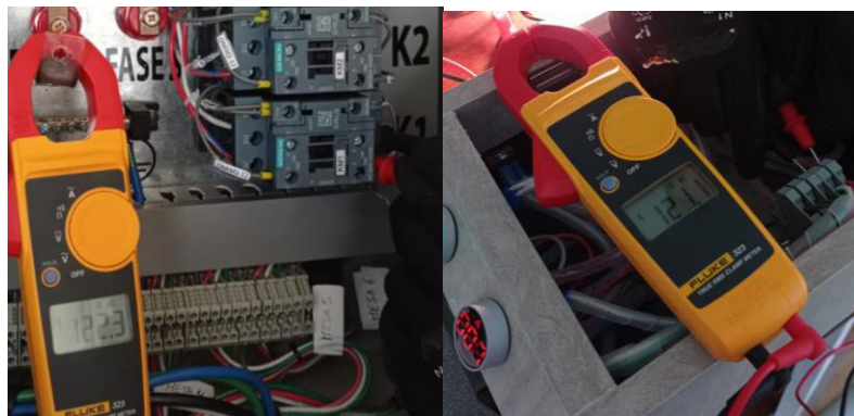
Figura 3.7 Voltaje medido en el tablero de control y módulo respectivamente
