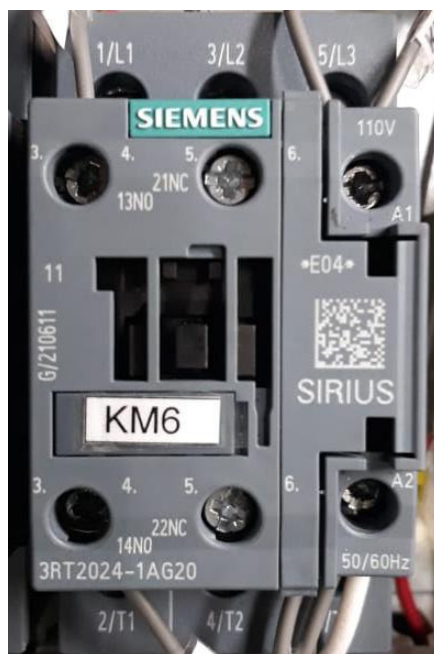
Figura 2.3 Contactor AC-3 12 (A) para el control de los módulos
