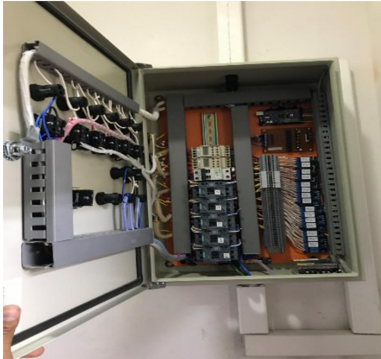
Figura 2.1 Conexión de los elementos del tablero original [3]
