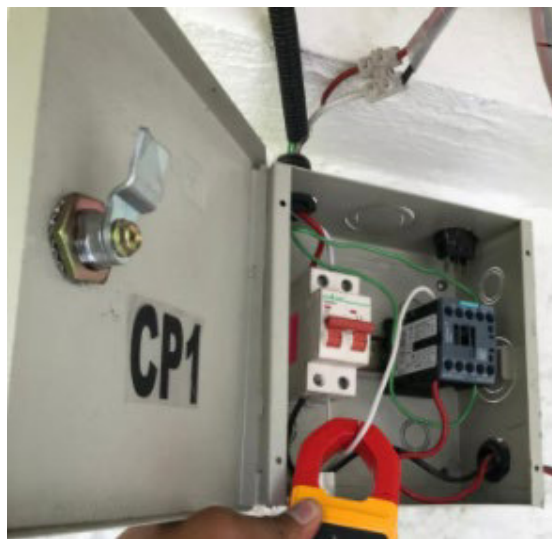
Figura 2.11 Montaje del contactor de repuesto en el Tablero 1
