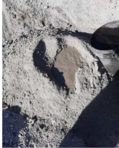
Figura 2.2. Adición de la cantidad de agua a la mezcla.
