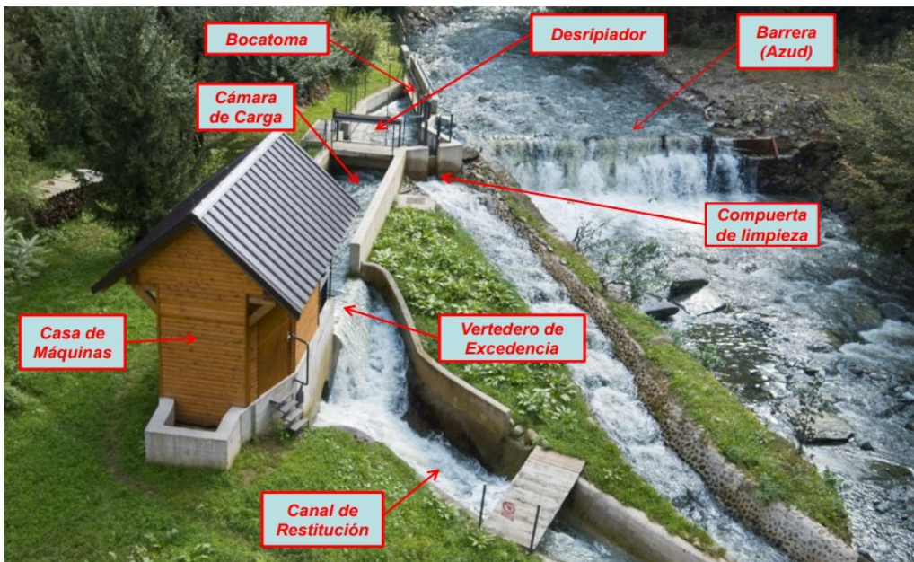
Figura 1.3 Partes de una central mini hidráulica, [4].
