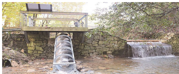
Figura 1.2 Central mini hidráulica con tornillo de Arquímedes, [3].
