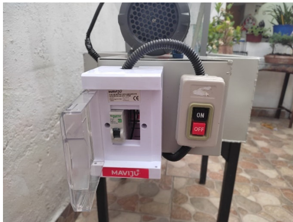
Figura 2.18 Sistema eléctrico de la bomba
