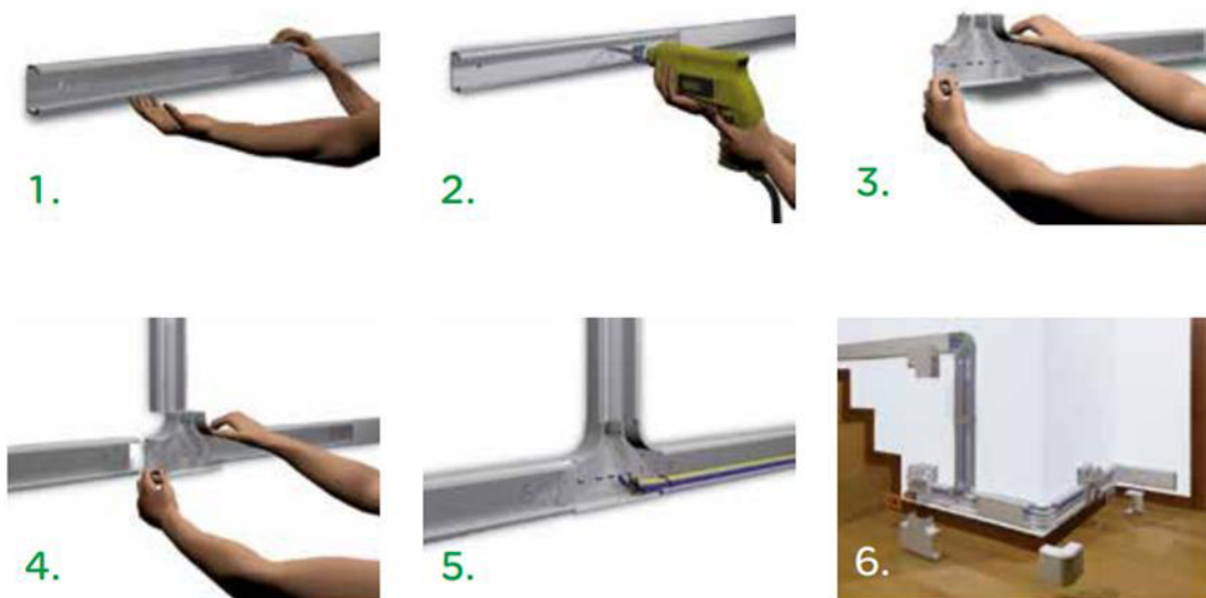
Figura 2.15 Instalación de canaletas, [14].
