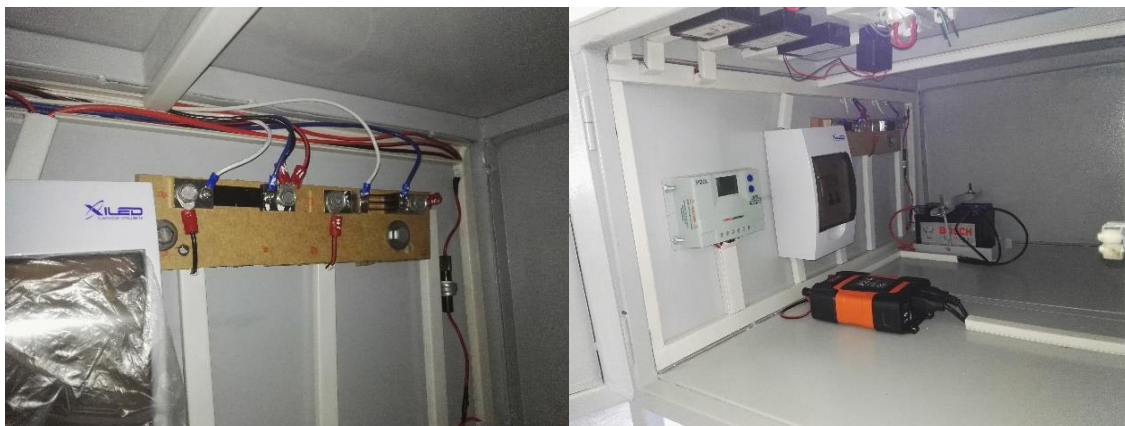
Figura 2.19 Conexión y colocación de canaletas.
