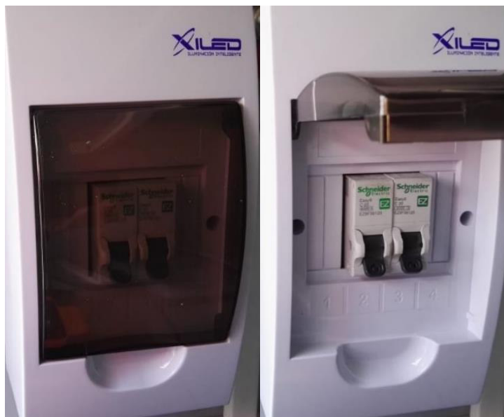
Figura 2.11 Fusible para el controlador, la batería e inversor, [20].
