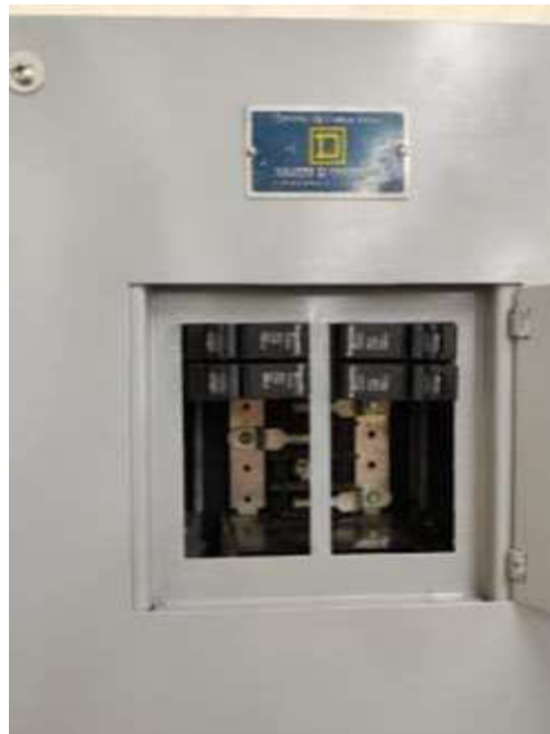
Figura 3.8. Estado actual del tablero
