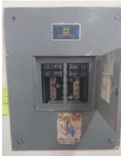
Figura 3.7. Estado anterior del tablero
