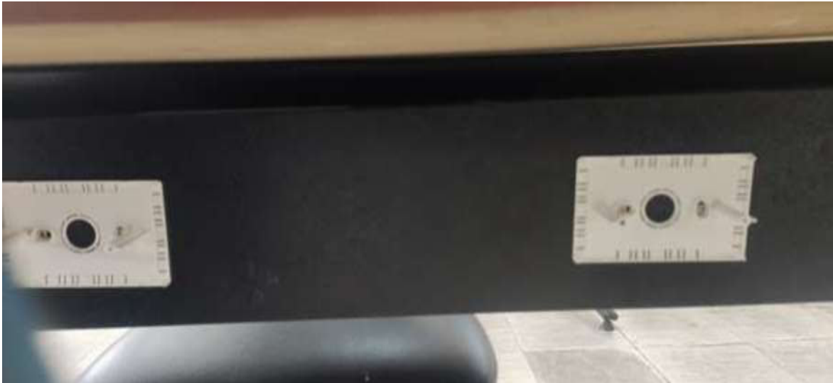
Figura 3.13. Colocación fija de los cajetines
